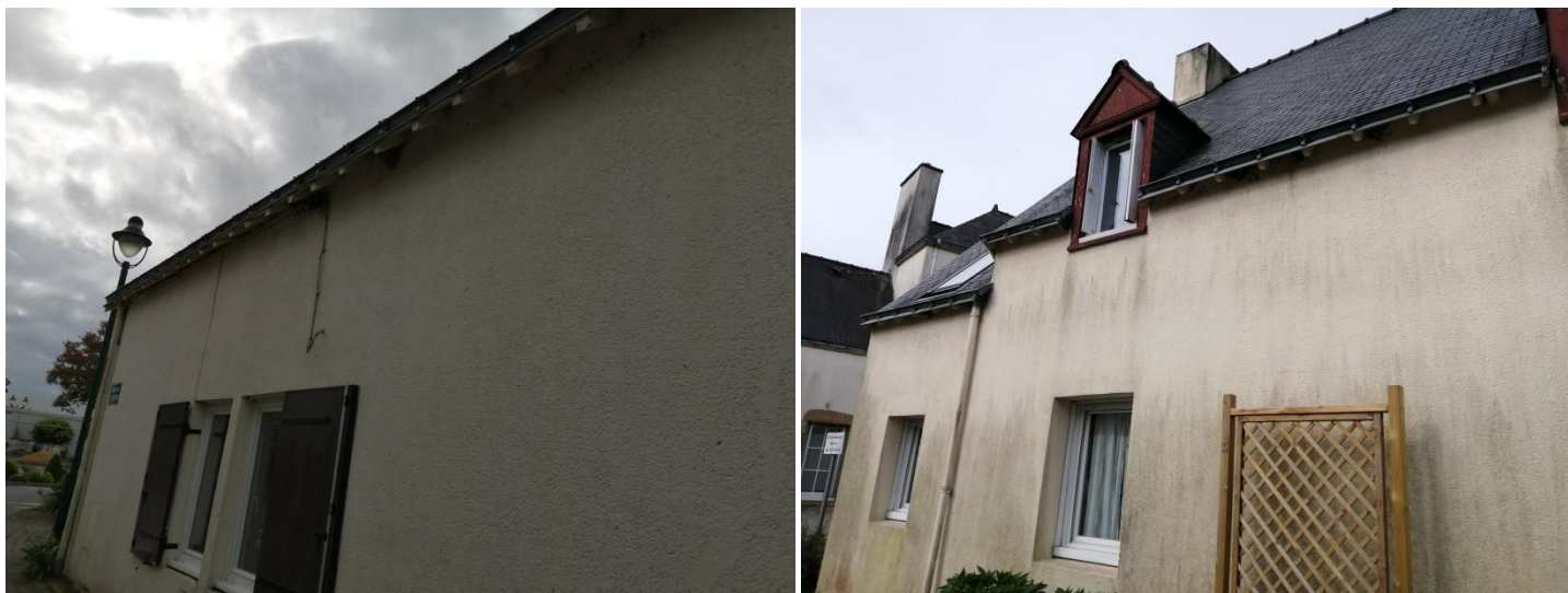
Résidence des Tilleuls à Arzal
